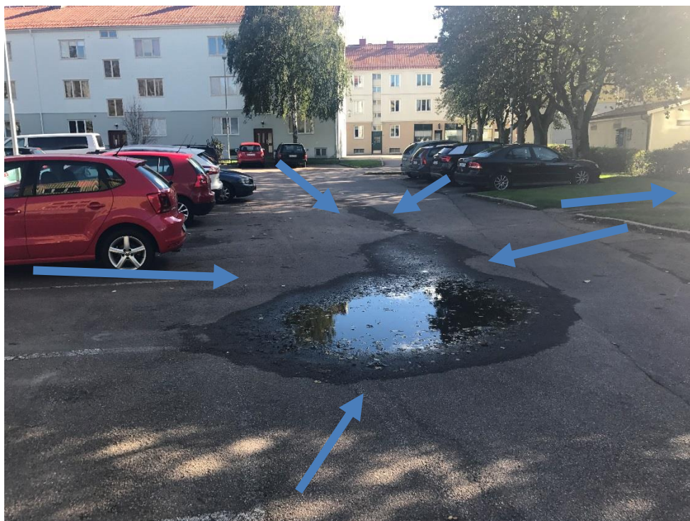
Figur 6: Foto taget i östlig riktning mot parkeringen och passagen mot Lars Kaggsgatan med lågpunkt mellan parkeringsplatserna.
